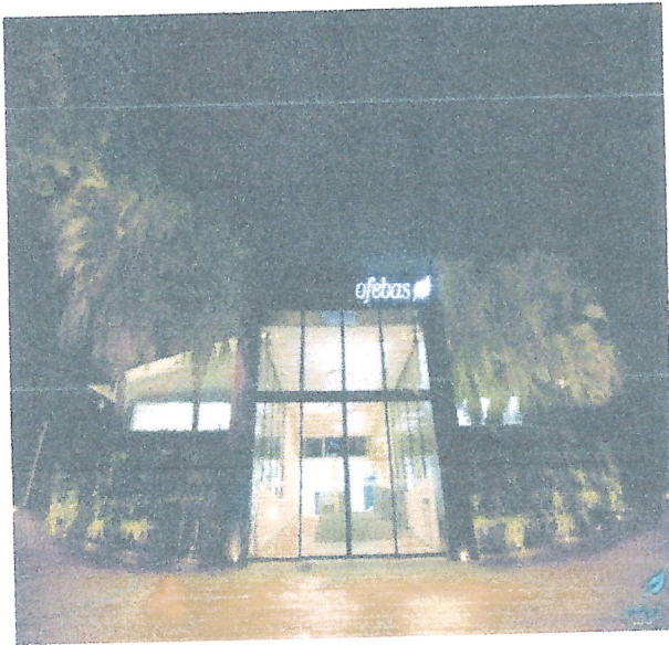
Fachada Principal Sorocaba - Matriz
