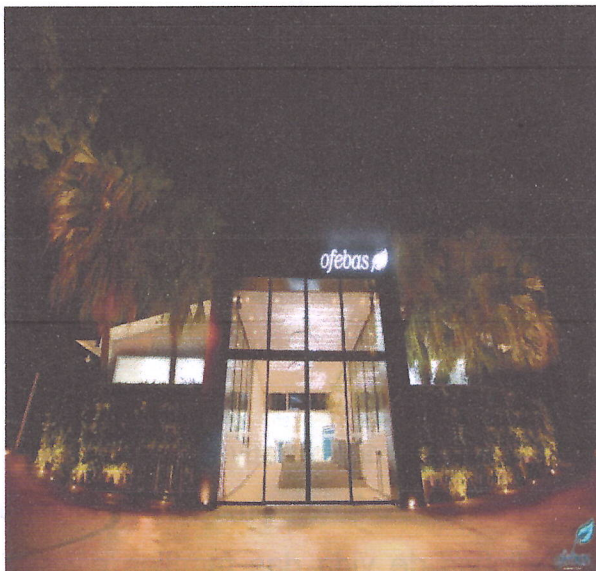
Fachada Principal Sorocaba - Matriz
